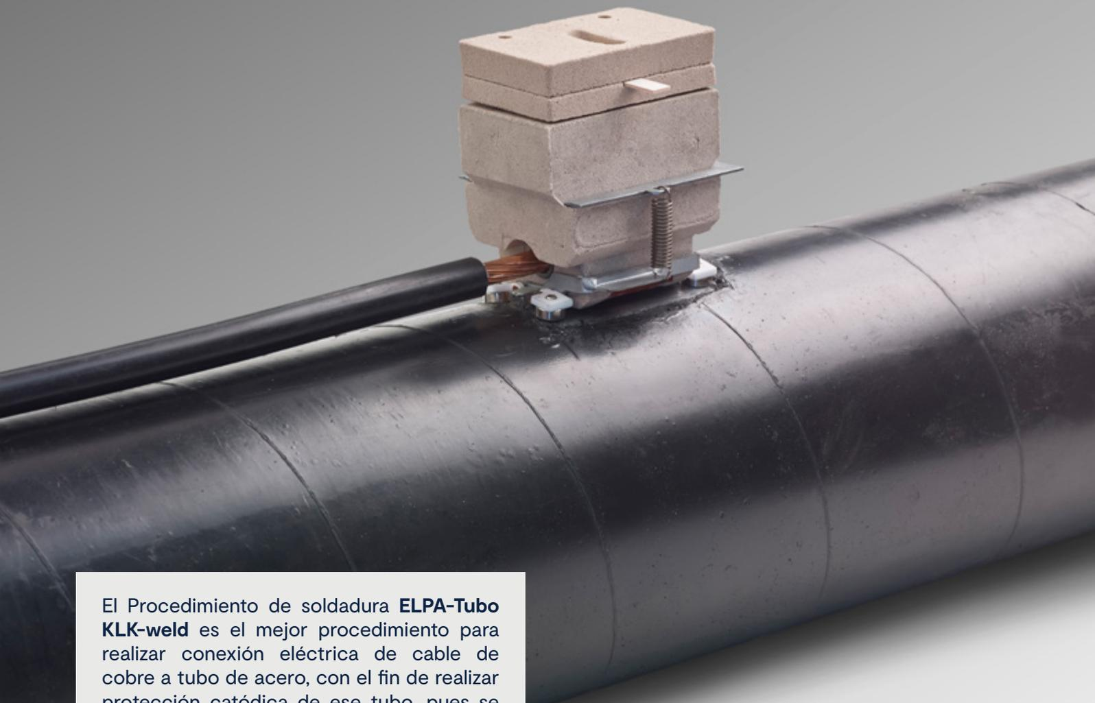
El Procedimiento de soldadura **ELPA-Tubo** **KLK-weld** es el mejor procedimiento para realizar conexión eléctrica de cable de cobre a tubo de acero, con el fin de realizar protección catódica de ese tubo, pues se consigue una baja resistividad eléctrica y una alta resistencia mecánica en la conexión, todo ello sin afectar al acero del tubo, pues la temperatura en el mismo no supera los 450 °C.
